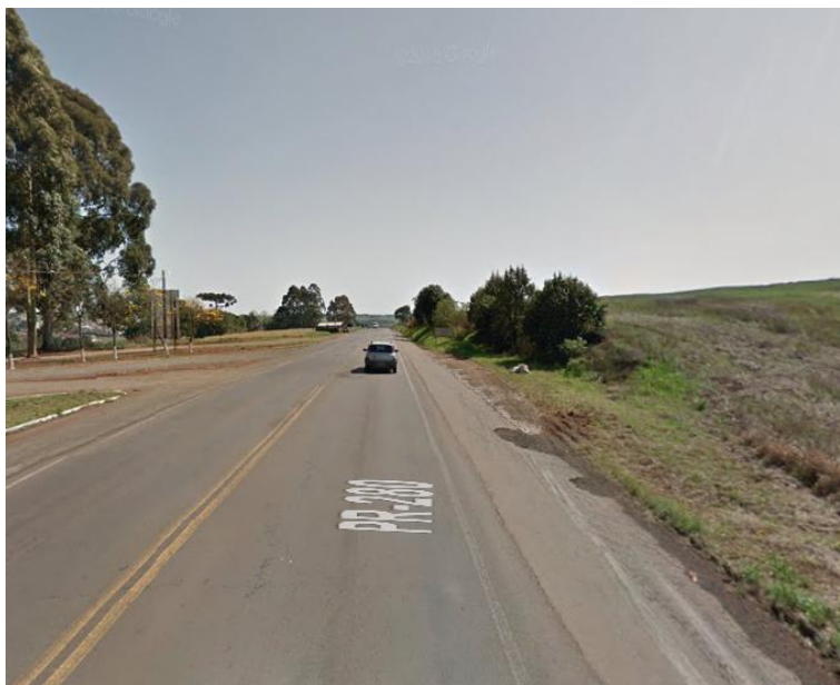
Detalhes do acesso
